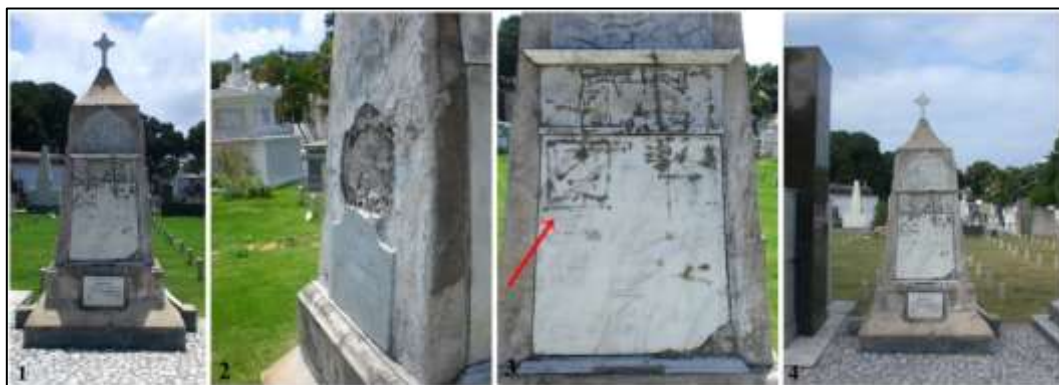
Figura 4: Modelo das fotografias. 1. Foto do túmulo como um todo; 2. Foto da lateralidade; 3. Foto das patologias existentes; 4. Foto geral. Fonte: Gisele Costa, 2014
