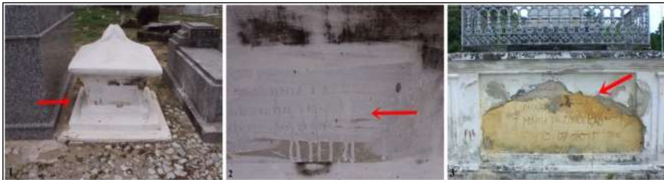
Figura 10: Medidas de conservação inadequadas existentes no Cemitério de Santo Amaro
