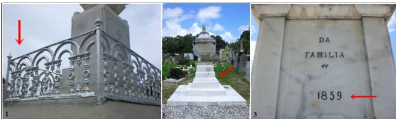
Figura 9: Medidas de conservação inadequadas existentes no Cemitério de Santo Amaro
