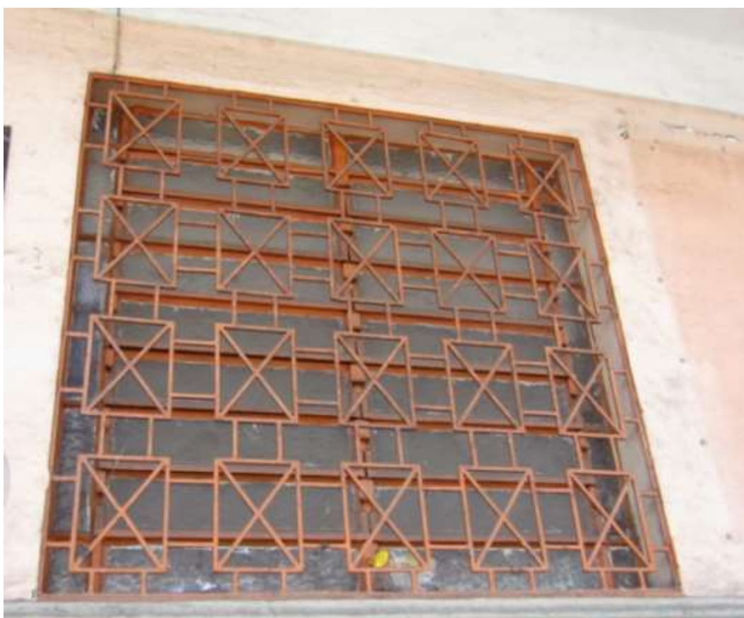
Figura 12: Grades de ferro, bairro da Encruzilhada, Recife – PE.
