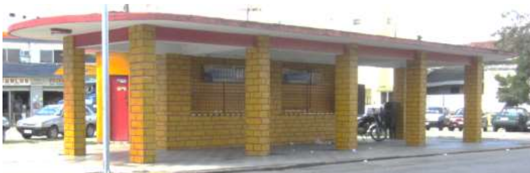
Figura 6: Abrigo de Ônibus. Exemplar único, bairro de Campo Grande, Recife – PE.
