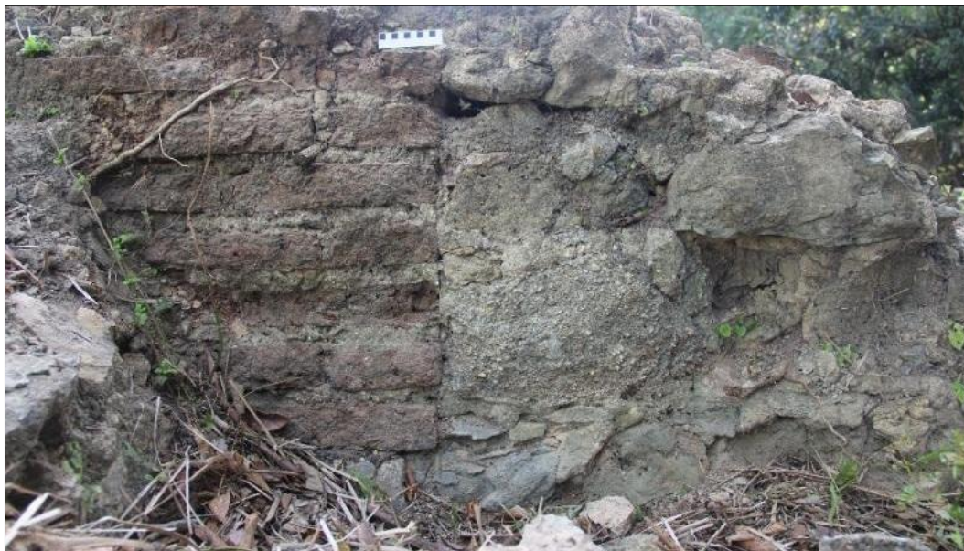
Figura 19: Ligação entre as paredes do altar e sacristia. Fonte: Paulo César Nery, 2018.
