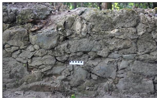
Figura 24: Detalhe da parede lateral direita da sacristia Fonte: Paulo César Nery, 2018
