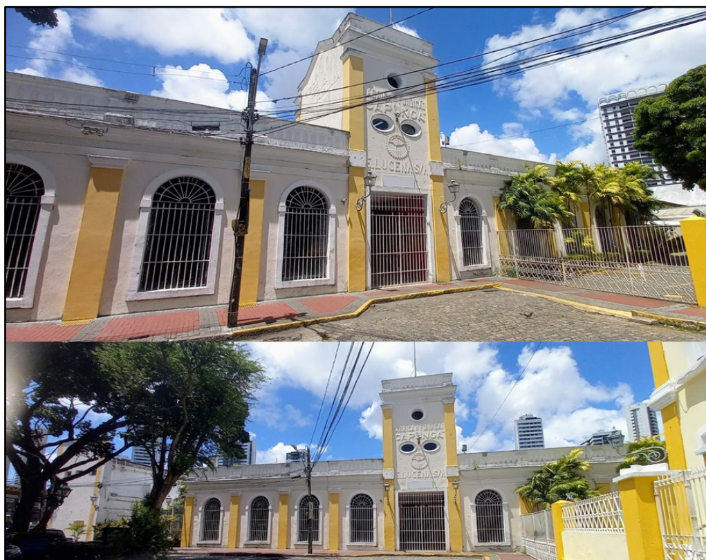
Figura 5: Fachada principal da antiga Fundação Capunga (F. Lucena s/a). Atual bloco C da Uninassau. Fotos: Gepipe (2022).
