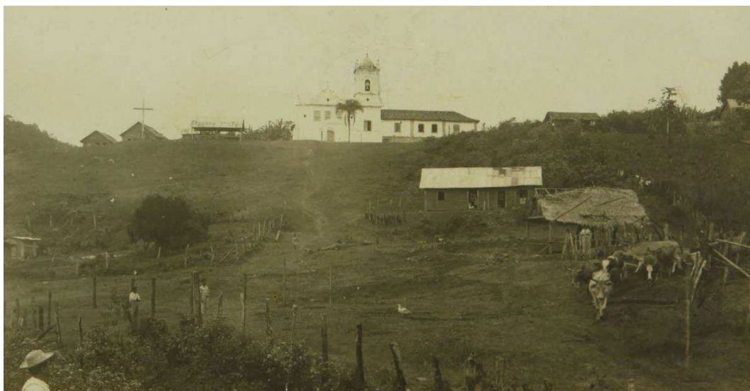
Figura 4: Foto da Igreja Nossa Senhora da Ajuda, em Araçatiba, sem autor (início do século XX). É possível notar a presença do casarão ainda erguido, ao lado da torre da igreja. Fonte: Fundo documental do Iphan-ES.
